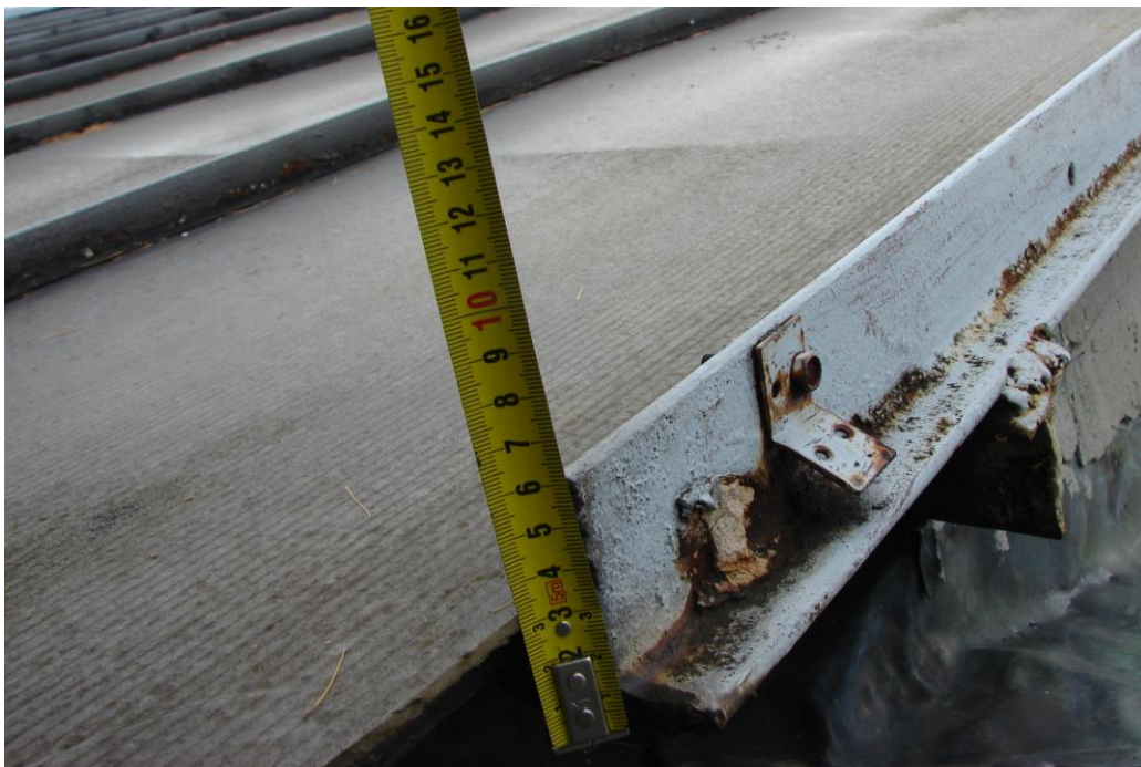
Główny profil nośny połaci świetlika 1/2IPE120
